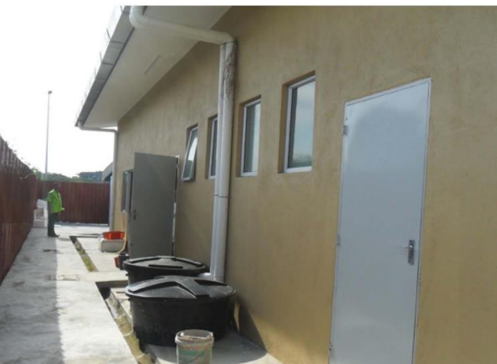
Pemasangan SPAHS Di Lot Kedai Berkembar
