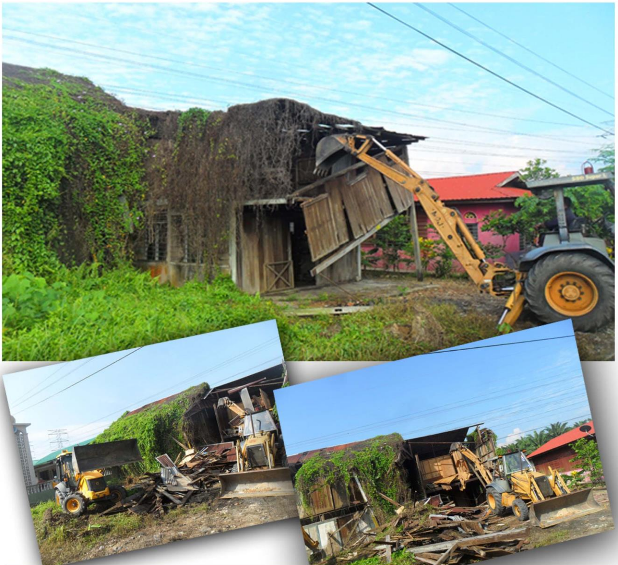
Operasi Merobuhkan Bangunan Usang
