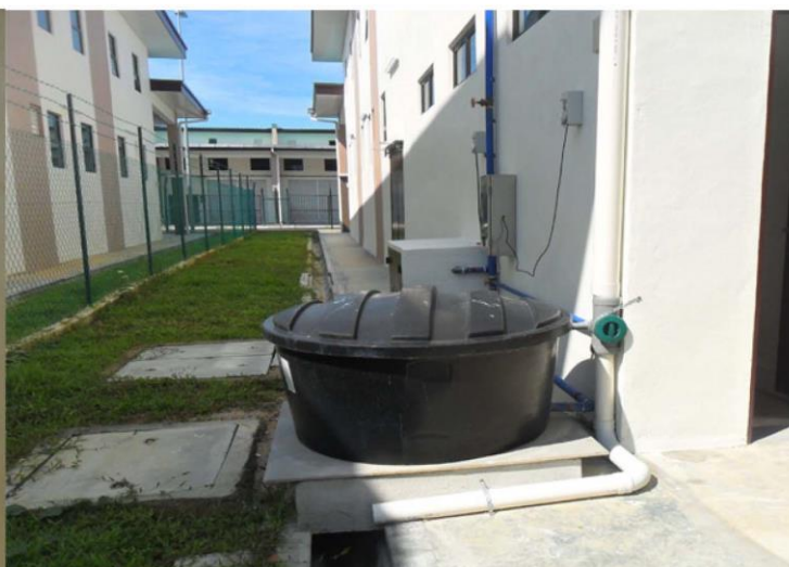
Pemasangan SPAHS Di Bangunan Komersial
